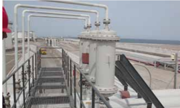
Odvzdušnenie potrubí: PROTEGO® BE/SRL - separátor kvapalného plynu
